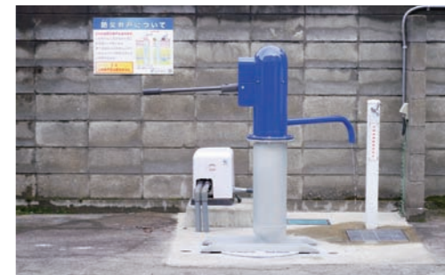
図3 新デザインの手動ポンプ試作品
