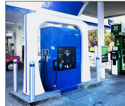
世界初の商用 3ノズル 水素ディスペンサーを 設置 (California)
