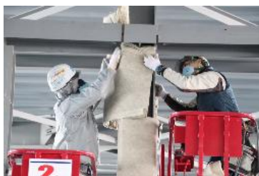
マキベエ（耐火被覆材）の施工現場
