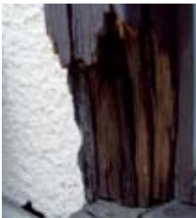
図1 壁際の腐朽例
