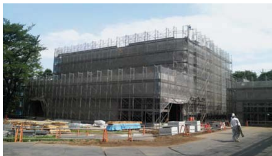
図2 EMCサイト（工事風景 5月12日撮影）
