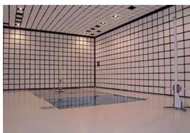
図5 10m法電波暗室の内観
