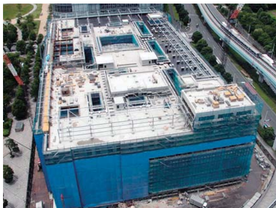
図1 新本部建設現場全景 (H22.7.15撮影)
