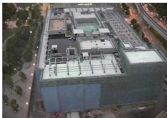
図1 新本部建設現場全景 (H22.8.20撮影)
