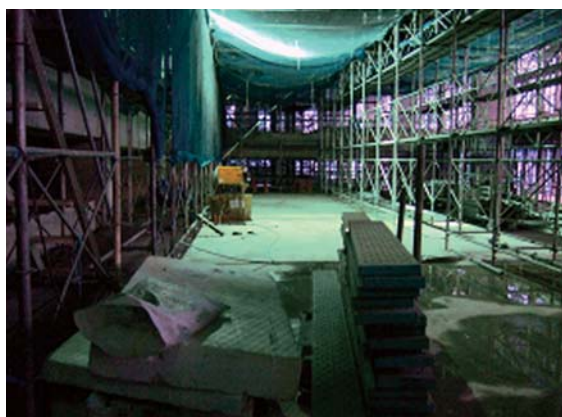
図2 東京イノベーションハブ工事状況 天井仕上げ作業 (H22.6.23撮影)
