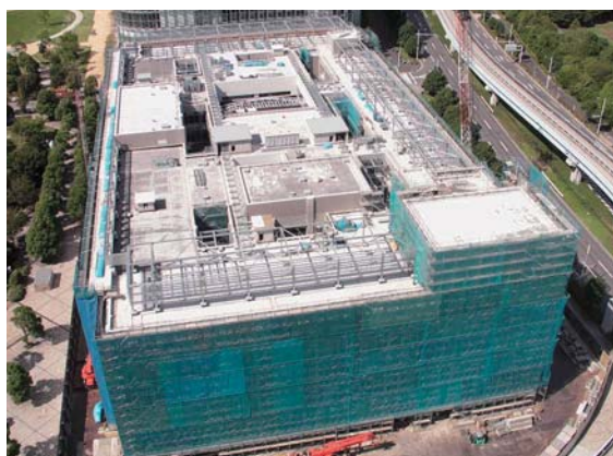
図1 新本部建設現場全景 (H22.9.26撮影)
