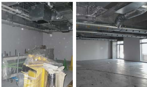
図2 製品開発支援ラボ工事状況 左) 化学系ラボ、右) 機械系ラボ (H22.10.13撮影)
