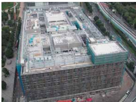
図1 新本部建設現場全景 (H22.10.18撮影)
