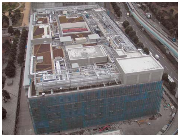
図1 新本部建設現場全景 (H22.12.13撮影)
