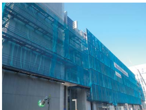
図2 新本部建設現場背面
