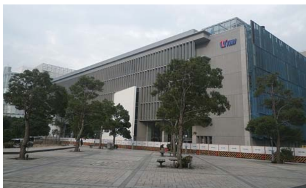
図1 新本部建設現場全景
