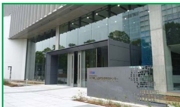
図1 エントランス
