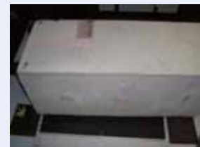
コンクリート柱
